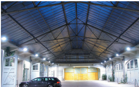
Ansicht des Dachtragwerkes Richtung Norden.
